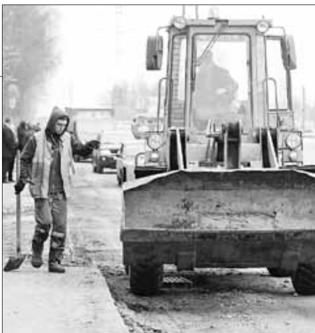
■ Работы на улице Павла Усова
